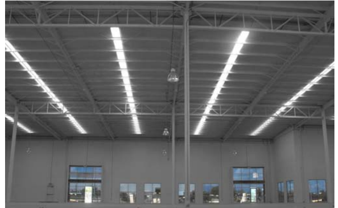
Bodega terminada con MBI Fiberglas ® donde se muestra una mejor en la iluminación de la nave.
