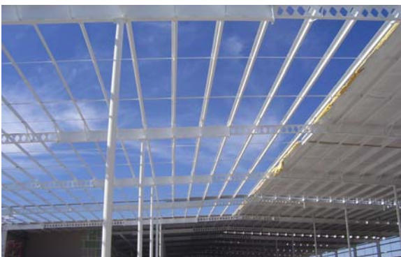
Instalación de fibra de vidrio de sobre una estructura metálica en México.
