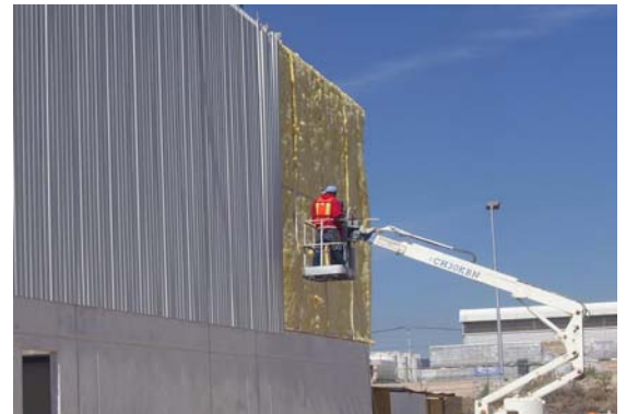
Aplicación de MBI Fiberglas® en el muro de una nave metálica.
