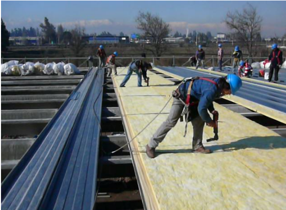
Instalación de MBI Fiberglas® sobre una nave industrial en Chile.
