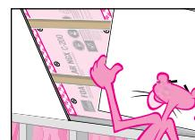
**1. INSTALLATION DE PANNEAUX ISOLANTS RIGIDES AU PLAFOND** Une fois l'isolant en nattes posé en affleurement de la sous-face de l'ossature, fixez les panneaux rigides FOAMULAR<sup>MD</sup> NGX<sup>MD</sup> CodeBord<sup>MD</sup> ou C-200 à l'ossature du plafond à l'aide de clous et de rondelles.
