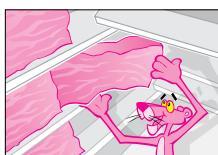
**2. Installation de l'isolant en matelas.** Utilisez des morceaux distincts d'isolant FIBERGLAS<sup>MD</sup> pour les événements et les poutres de pignon. N'essayez pas de poser une longueur continue d'isolant à l'endroit où les poutres de pignon et les chevrons se rejoignent, car ceci peut créer des espaces difficiles à remplir. Disposez les matelas entre les chevrons jusqu'à ce qu'ils soient de niveau avec la partie inférieure du bois.
