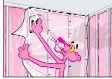
**3. Installation de l'isolant en matelas.** Placez les matelas entre les montants de sorte qu'ils soient posés en affleurement de la face intérieure des montants. Veillez à bien couvrir la solive de rive avec l'isolant, car les pertes de chaleur peuvent être importantes.
