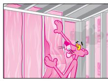
**2. Découpe des matelas.** Découpez des morceaux de matelas et posez-les à l'intérieur de la solive de rive, entre la sablière supérieure et la sous-face du plancher.
