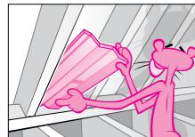
Mesurez en (mm/po) l'épaisseur de l'isolant déjà installé dans votre grenier. Reportez-vous au Guide de produit pour l'isolant ROSE FIBERGLAS<sup>MD</sup> NOUVELLE GEN<sup>MD</sup> pour calculer la quantité d'isolant requise afin d'atteindre 599 mm (23,6 po) d'épaisseur.
