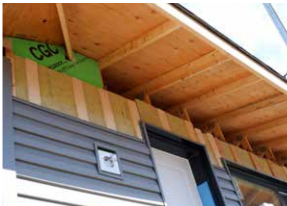
Figure 13 : Photo de l'isolant continu extérieur en laine minérale Thermafiber MD RainBarrier MD Plus (110) à compression élevée de 51 mm (2 po) et fourrures sous le parement en vinyle. Source : SAIT
