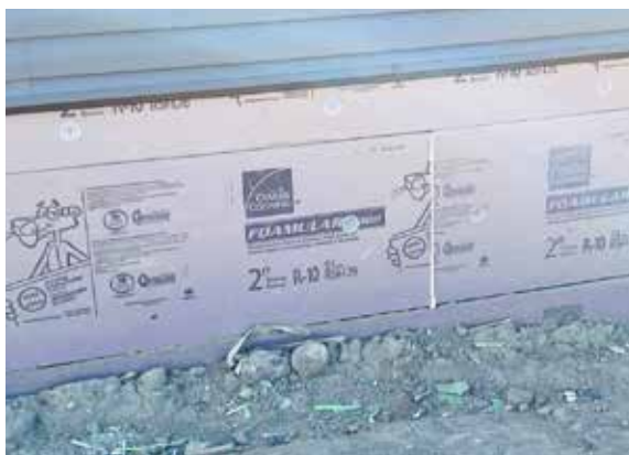
Figure 15 : Isolant extérieur sous le niveau du sol mettant en valeur l'isolant de polystyrène extrudé rigide FOAMULAR MD C-300 de 51 mm (2 po). Source : SAIT
