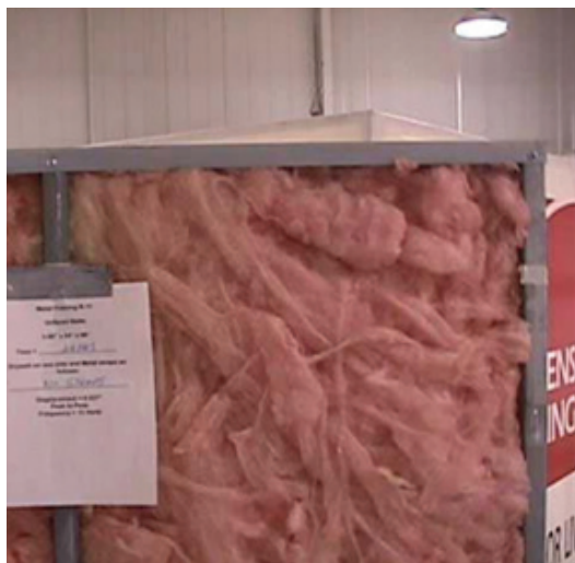
Figure 3 Aucun affaissement mesurable de l'isolant en matelas R-11 dans un mur de 16 pi de hauteur
