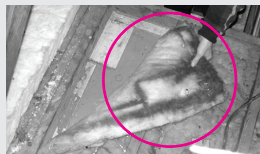
Figure 5 Isolant en matelas décoloré
