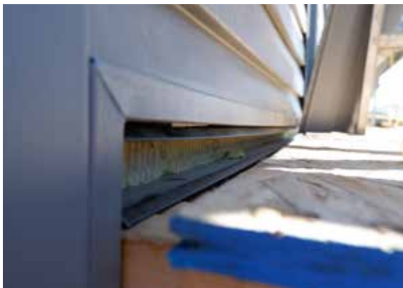
Figure 12 : Photo du double solin et des détails de l'isolant installé autour de la plate-forme installée à l'arrière de la maison. Source : SAIT
