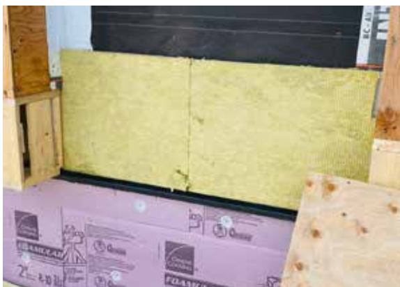
Figure 14 : Transition entre un mur au-dessous du niveau du sol et un mur au-dessus du niveau du sol mettant en valeur l'isolant continu en laine minérale Thermafiber MD RainBarrier MD Plus (110) à compression élevée de 51 mm (2 po) et l'isolant de polystyrène extrudé rigide FOAMULAR MD C-300 de 51 mm (2 po). Source : SAIT
