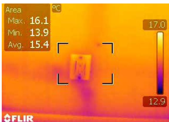
Figure 8 : Infiltration thermique minimale observée à partir de l'ossature entourant un appareil d'éclairage. Source : SAIT
