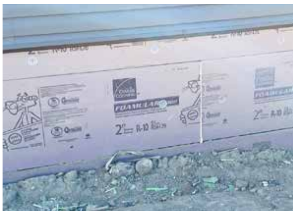
Figure 15 : Isolant extérieur sous le niveau du sol mettant en valeur l'isolant de polystyrène extrudé rigide FOAMULAR MD C-300 de 51 mm (2 po). Source : SAIT
