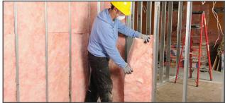
**Matelas insonorisants ROSE NEXT GEN<sup>MC</sup> FIBERGLAS<sup>MD</sup> QUIÉTUDE<sup>MD</sup>** : Matériau absorbant le son pour divers assemblages intérieurs de planchers, de plafonds et de murs porteurs et non-porteurs à indice d'insonorisation et de résistance au feu. Conçu pour aider à contrôler la transmission du son en absorbant les vibrations sonores.
