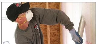
**Système d'isolation des murs ProPINK<sup>MD</sup>** : Isolant thermique en fibre de verre en vrac pour une installation dans des assemblages de murs ou de plafonds à l'aide d'un équipement pneumatique commercial, d'un matériau non tissé et de la jauge de densité Inspect-R<sup>MD</sup>. La résistance thermique dépend des dimensions de la cavité et de la densité de l'isolant soufflé.
